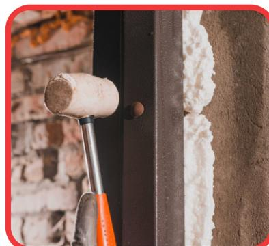
É uma espuma adesiva, e seladora em aerossol a base de poliuretano. É monocomponente e quando reage com a umidade do ar torna-se, após a cura, uma espuma semirrígida, com propriedades polivalentes, como fixação, adesão, isolamento e preenchimento. É indicado para uma vasta gama de aplicações em construções.
