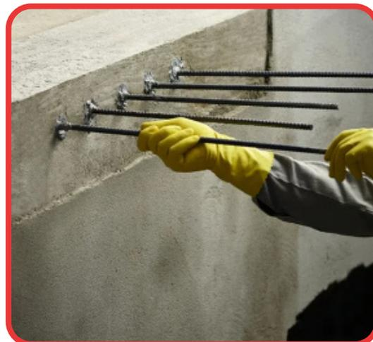
Flexsell Compound Adesivo é um adesivo estrutural de base epóxi que apresenta altas resistências mesmo em estágios iniciais de cura, tornando-o ideal para aplicações que exigem rápida resistência estrutural. A média fluidez do adesivo permite um manuseio fácil e preciso, garantindo uma aplicação suave e eficiente. Essa característica é especialmente útil em projetos onde a aderência precisa ser feita em áreas de difícil acesso ou em superfícies complexas.
