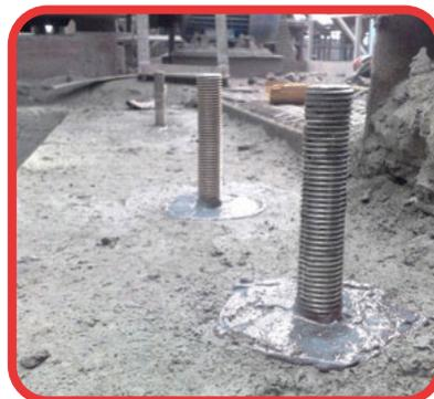
O chumbador químico Flexsell é um sistema de ancoragem extremamente eficiente, projetado para oferecer uma fixação robusta em uma ampla variedade de superfícies. Garante uma aderência superior em diferentes tipos de bases, como concreto, alvenaria e pedra. Ele foi desenvolvido para garantir uma ancoragem confiável em diversas aplicações, desde construções de grande porte até pequenos projetos de fixação.
