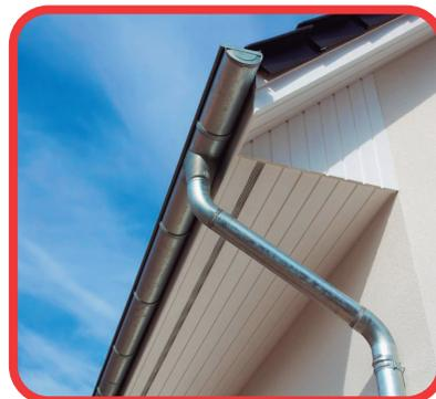
É um adesivo selante flexível monocomponente à base de poliuretano, desenvolvido para colagem e vedação de calhas, rufos, pingadeiras e condutores. Apresenta boa resistência às intempéries (raios UV) podendo ser aplicado na instalação, manutenção e reforma de telhados, resistindo à exposição direta ao sol e mantendo sua eficácia.
