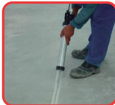
Desenvolvido para obras que requerem alta resistência na colagem e vedação entre elementos de estruturas pré moldados, juntas de dilatação estruturais internos e externos (vertical - fachadas / horizontal - pisos) com excelente resistência a raios U.V e intempéries.
